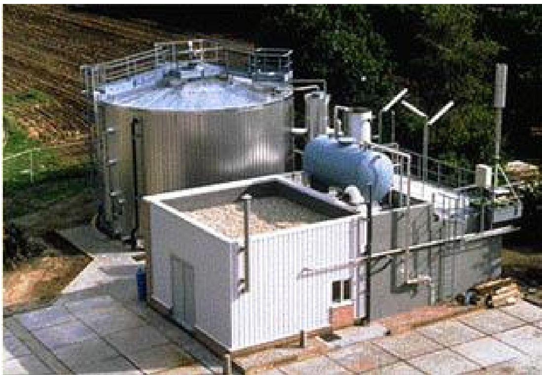
Hình 2.13. Một hệ thống lọc sinh học kỵ khí xử lý nước thải
