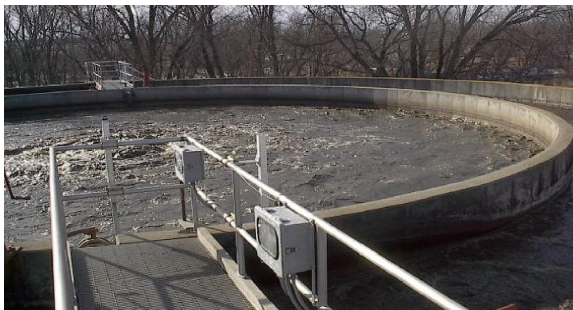
Hình 2.6. Hồ sục khí xử lý nước thải chăn nuôi
