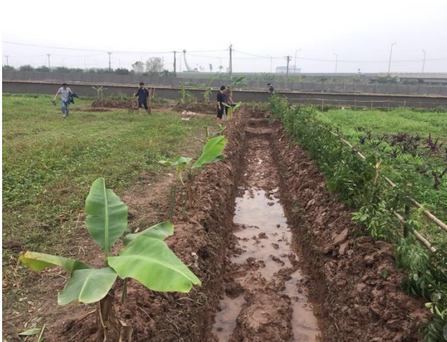
Xây dựng hàng rào, hệ thống tiêu thoát nước
